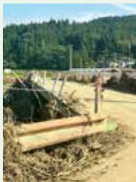
山形県酒田市長青沢地区、荒瀬川。川が氾濫し、流木が絡まった橋。
